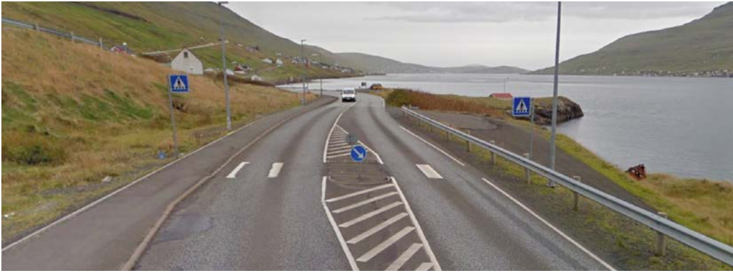
Mynd 27: Gonguteigur undir Gætueiði har tað bert er gongubreyt øðrumegin og smøl vegøksl við bilverju hinumegin. Merkingin er slitin upp og ikki natúrligt at fara yvirum.
